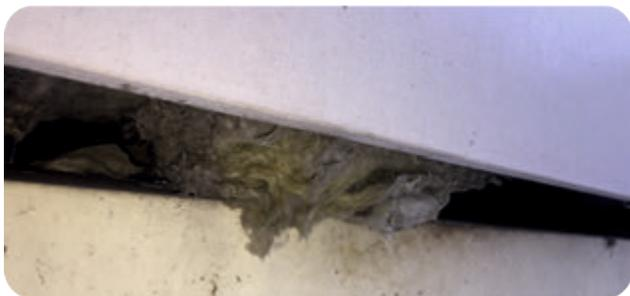
Деградация связующего состава утеплителя из-за воздействия воды и пыли
